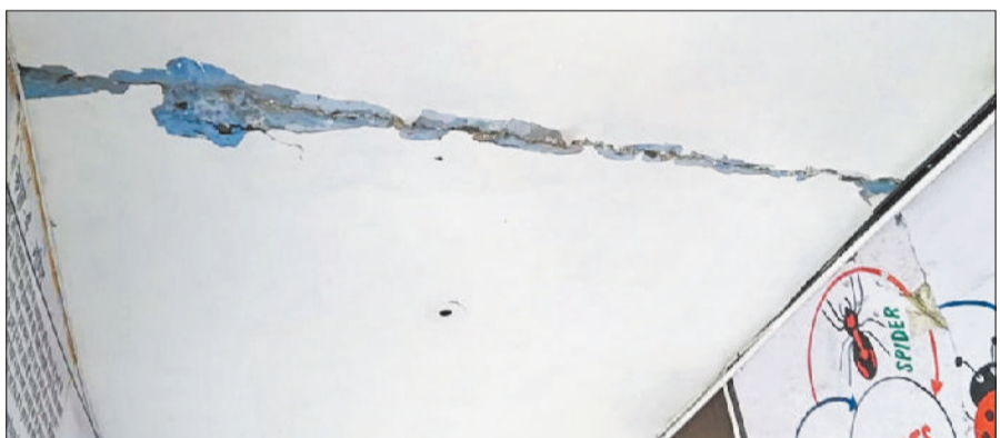
यमुनानगर। रादौर स्थित सरकारी स्कूल की छत में आई दरार।
